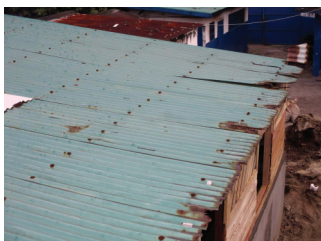
Toiture CM2 avant travaux
