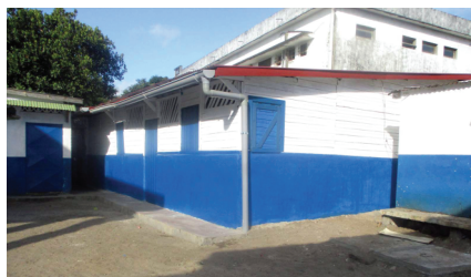
Bâtiment CM2 après travaux
